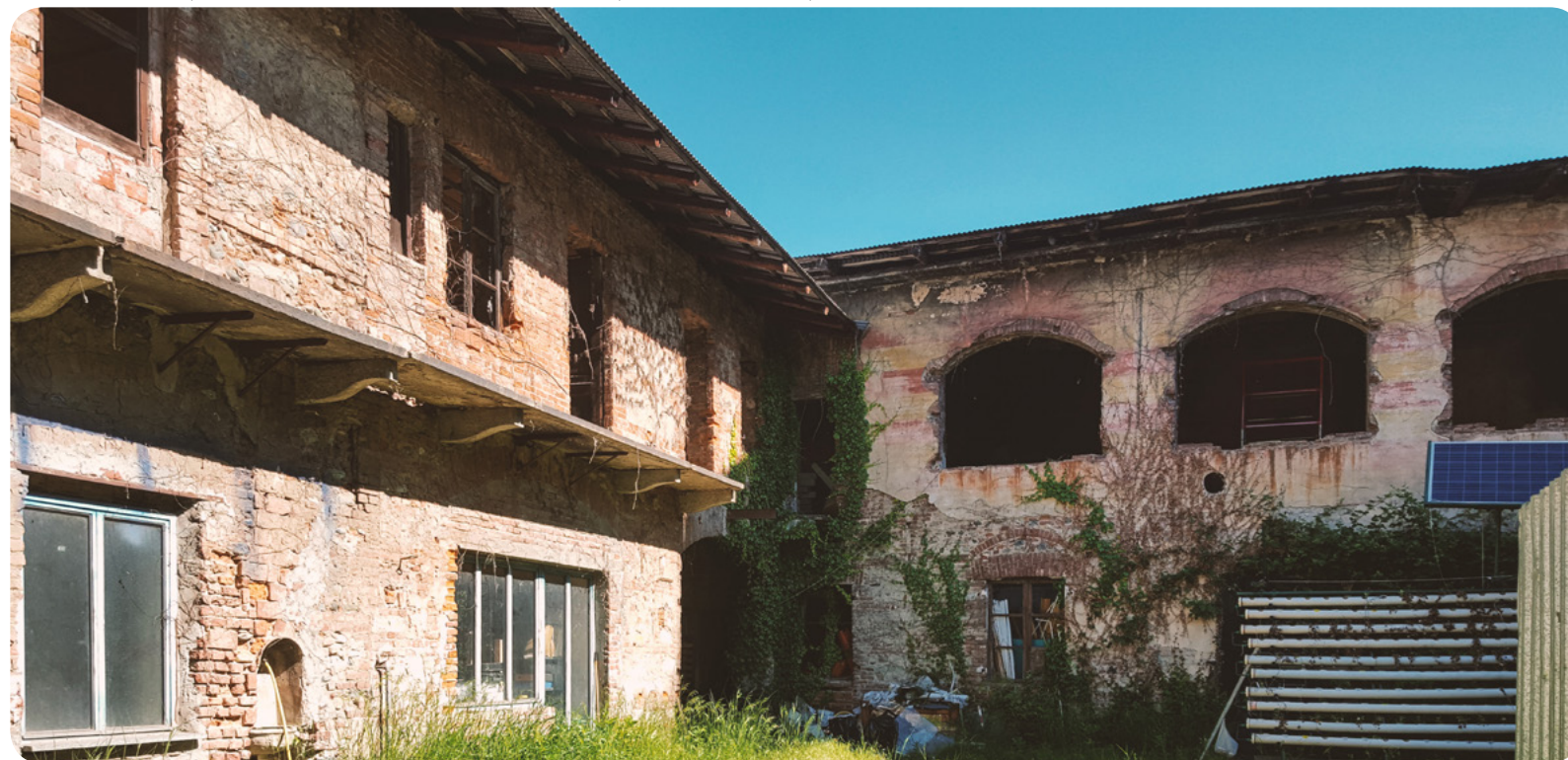
Prima - stato attuale della cascina
