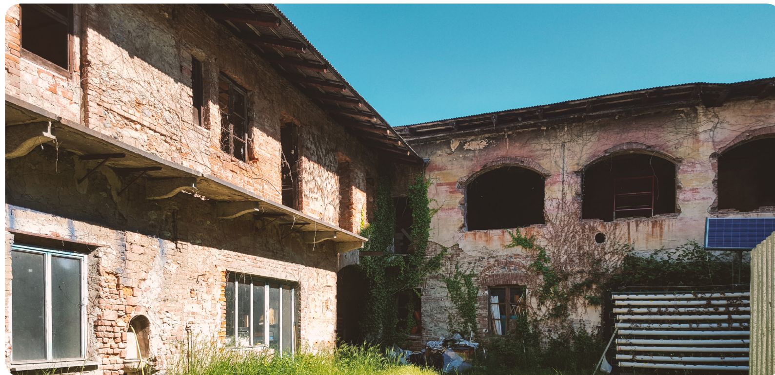
Prima - stato attuale della cascina
