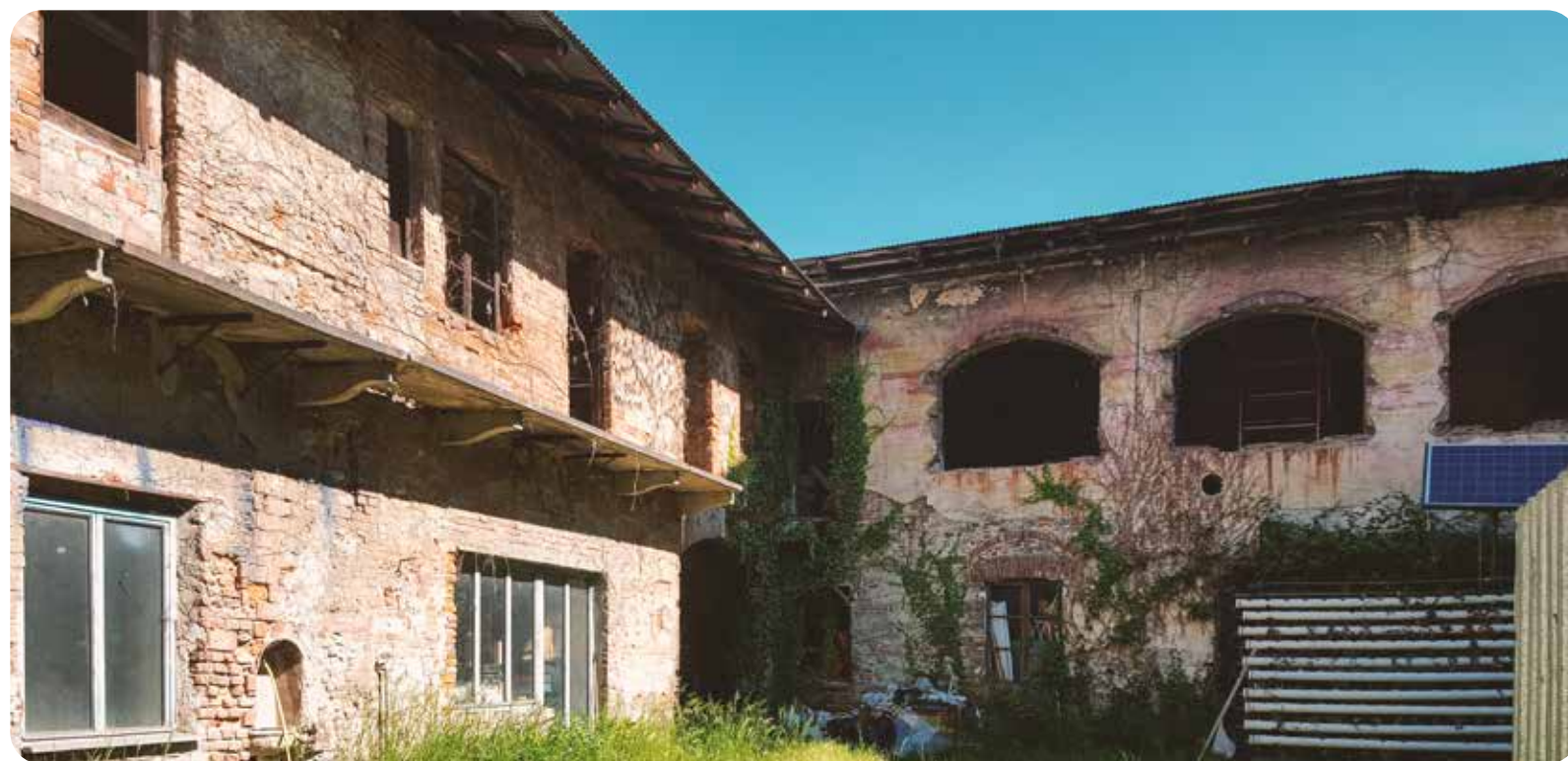
Prima - stato attuale della cascina
