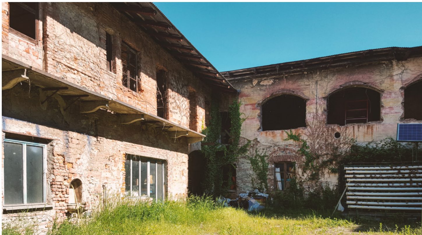
Prima - stato attuale della cascina
